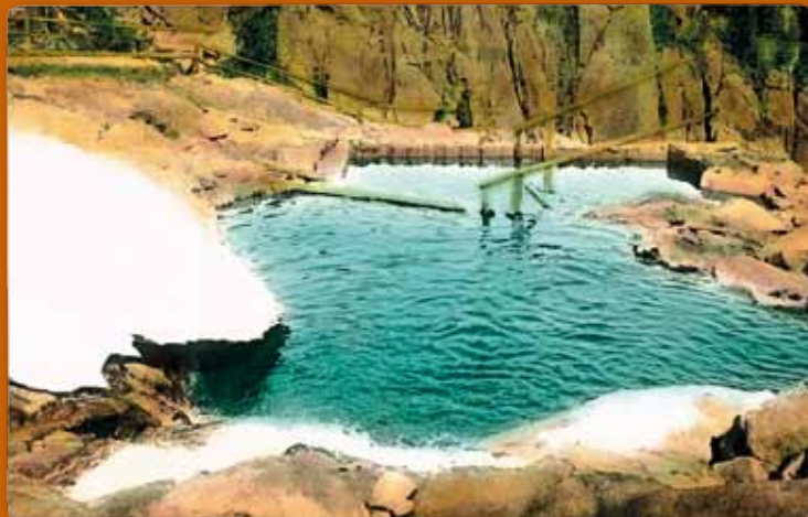
Na fotografii Josefa Vejnara z 1904 roku widać dwa małe zbiorniki nad Wodospadem Łaby, z dobrze widocznymi dźwigniami do wypuszczania wody i poręczą przy chodniku prowadzącym pod wodospad
