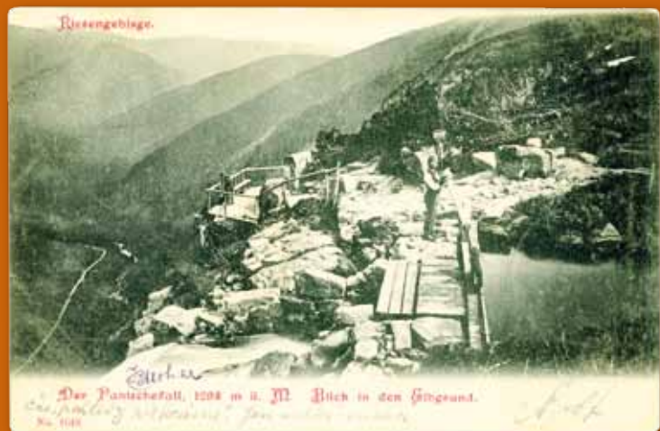
Obecnie już nieistniejący zbiorniczek do zwiększania przepływu wody nad Wodospadem Panczawy
