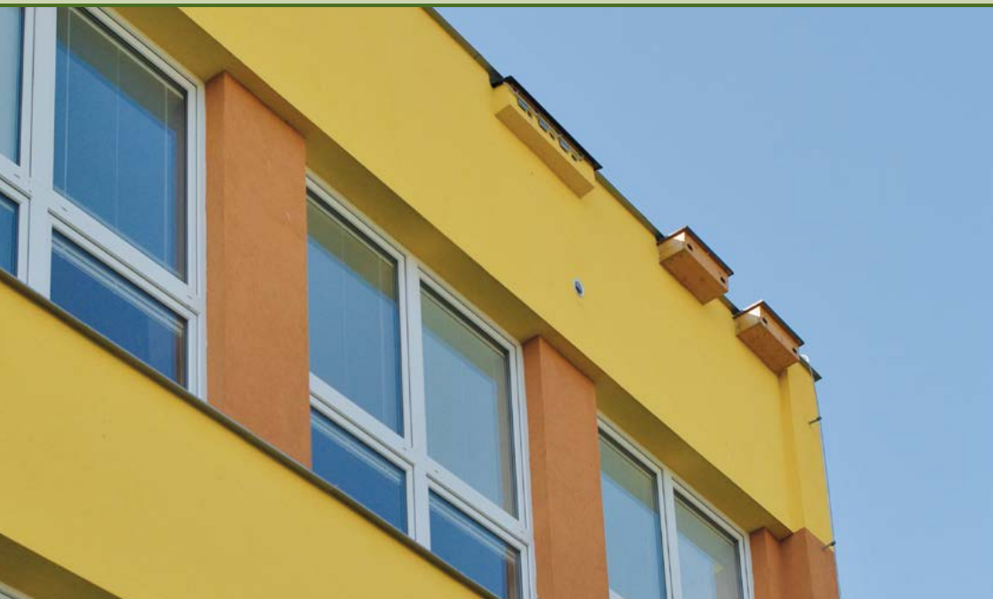
Ocieplony budynek szkoły w Vrchlábí z budką dla jerzyków
