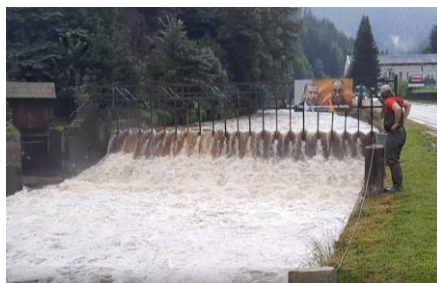
Obr. 2 Rozvodněná Úpa komplikovala práci geodetům.
