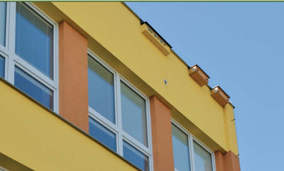
Zateplená budova vrchlabské školy s budkami pro rorýse
