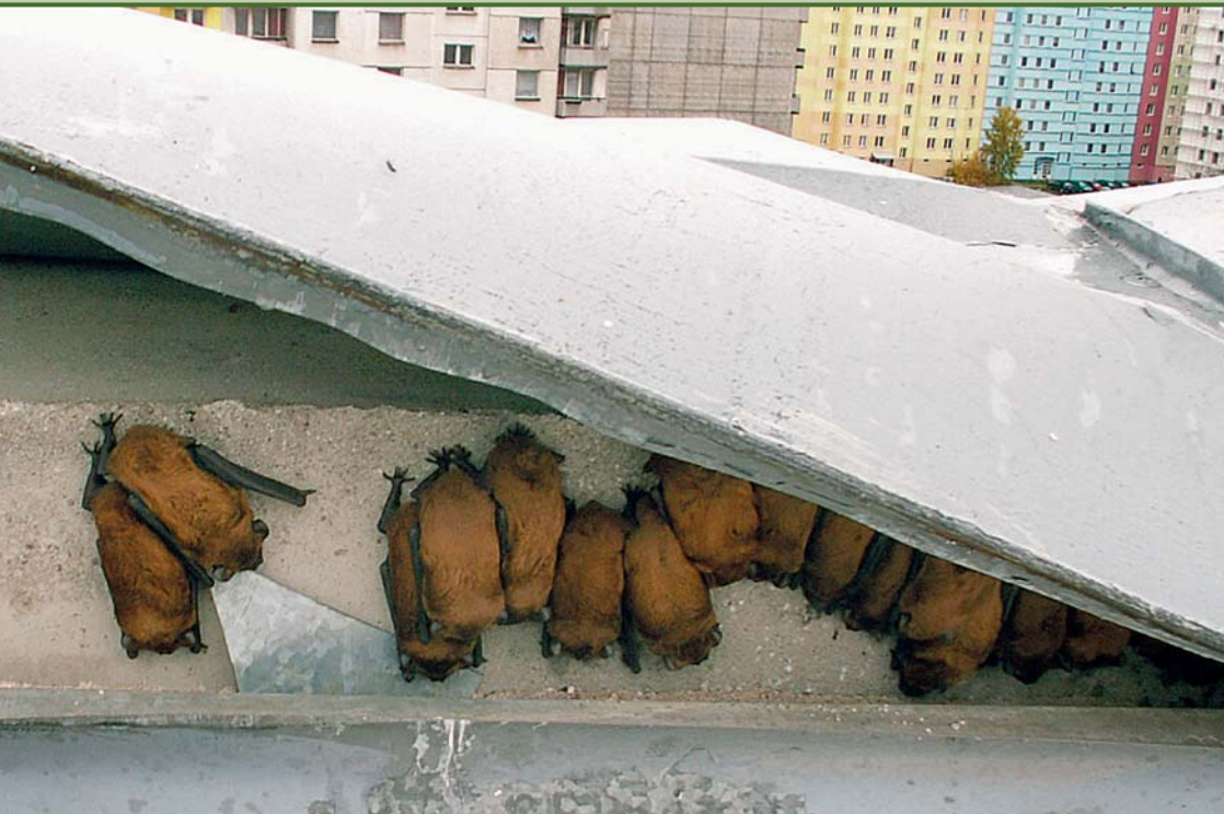
Zimoviště netopýra rezavého, objevené po odkrytí plechové střechy panelového domu
