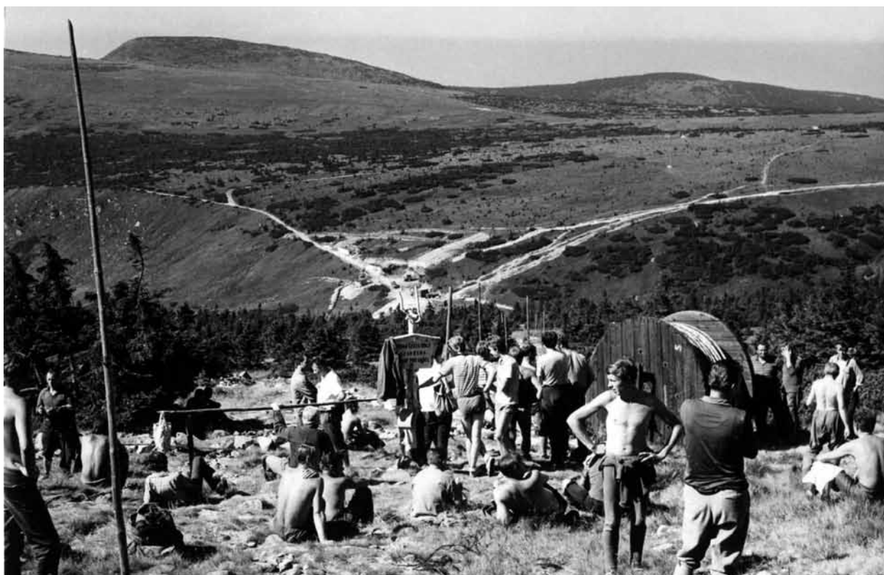
Pokládání kabelu od Labské boudy k Martinovce a ke Sněžným jamám, asi 1969. Podobně jako na Sněžku vede kabel a vodovod z polské strany, na Sněžné jámy vede kabel z Čech. Důsledná kabelizace Krkonoš trvá od roku 1965 dodnes. Za tu dobu byla nejen nahrazena povrchová vedení, ale byla také důsledně elektrifikována téměř všechna dosud nepřípojená místa (z velkých enkláv např. Klínové Boudy v roce 2008). K tomu je třeba připočíst linie sdělovacích kabelů. Liniové stavby jsou citlivou záležitostí, dodnes pečlivě sledovanou (foto Miroslav Hladík)
