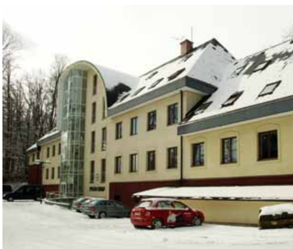
Oddělení Správy KRNP ve Vrchlabí byla dlouho rozmístěna na zámku, v muzejní budově a ve dvou provizorních dřevěných barácích. Po sloučení s lesními závody bylo vystavěno nové ústředí (dokončeno 1996, foto Kamila Antošová)
