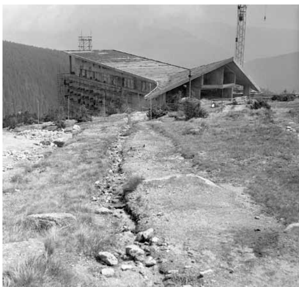
Poškození terénu v trase vodovodu pro novou Labskou boudu (foto Jan Štursa)
