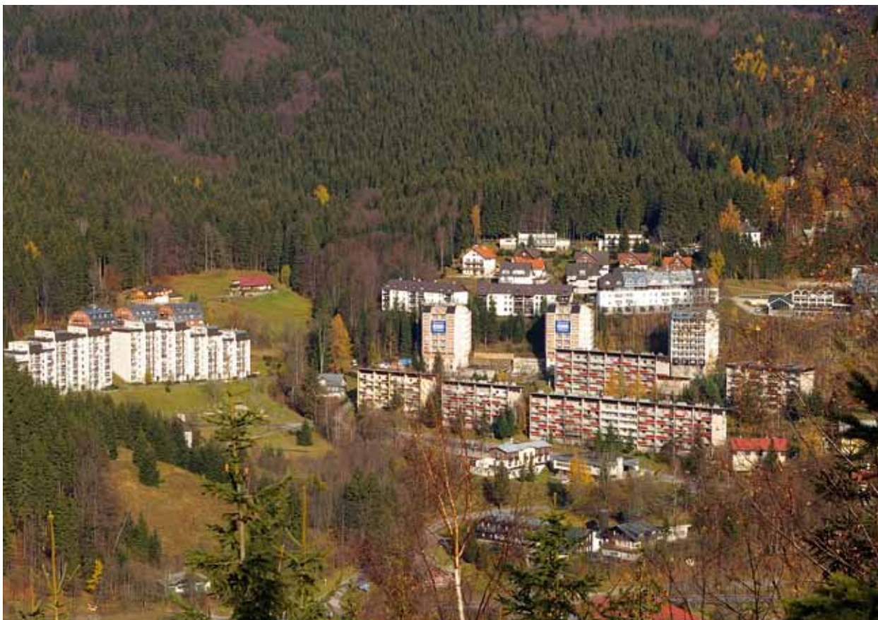
Sídlíště Bedřichov. Tři vysoké bytové domy už neslouží trvalému bydlení, nýbrž rekreaci. Na sídlíště navázala hustá zástavba rodinných penzionů (foto Kamila Antošová)
