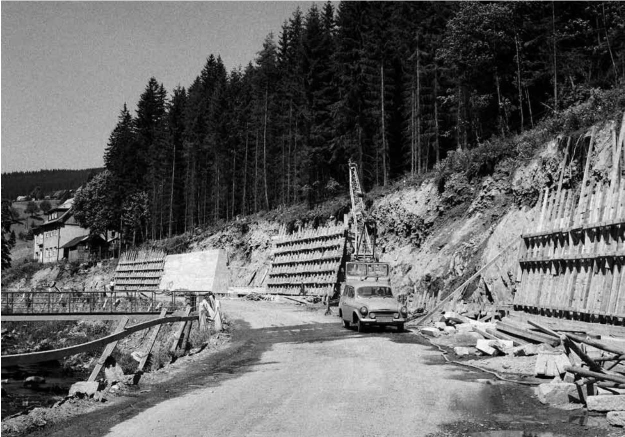
V roce 1969 byla zahájena série přestaveb silničních radiál vedoucích do krkonošských středisek a na hraniční přechody. Polské stavební firmy postupně do roku 1977 rozšířily silnice Horní Maršov—Pec pod Sněžkou (na obrázku), Vrchlabí—Špindlerův Mlýn, Temný Důl—Pomezní Boudy, Kořenov—Harrachov. Později přibyl obchvat Harrachova, oč zbytečnější, o to širší (foto Miroslav Hladík)
