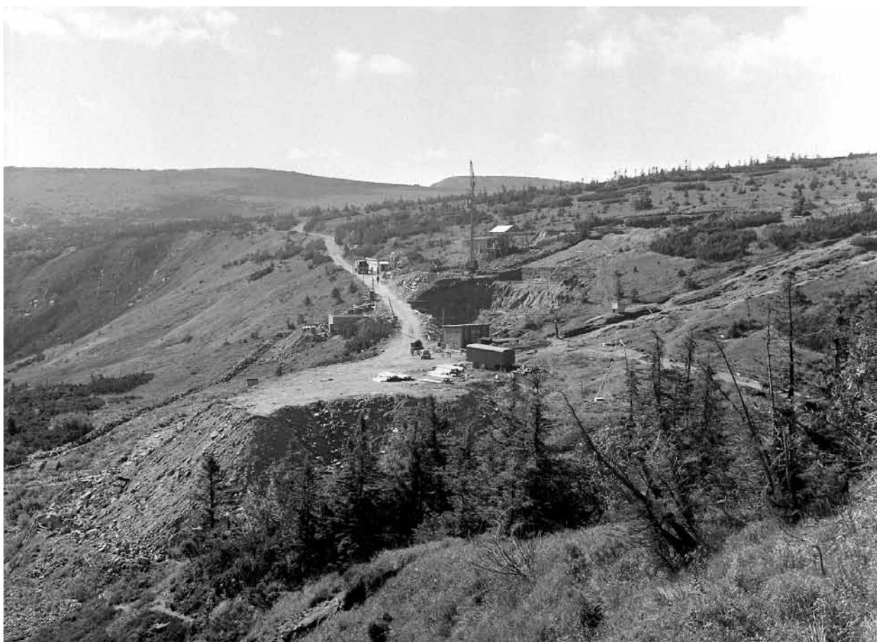
Výstavbě nové Labské boudy předcházely obrovské přesuny zeminy, které nevratně poznamenaly přírodu v okolí Labských jam (foto Jan Štursa)
