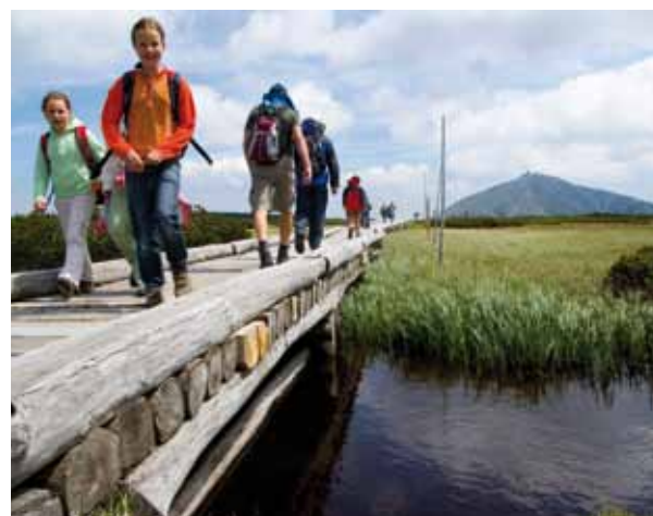
Přes revitalizované Úpské rašeliniště vede místo vápencového náspu povalový dubový chodník na pilotách (snímek z roku 2009, 13 let od výstavby, foto Kamila Antošová)
