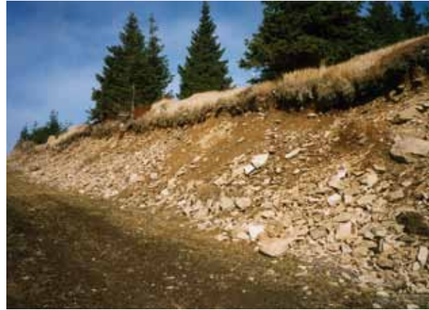
Detaily z Medvědína: dobře a špatně stabilizovaný okraj sjezdovky. Klouzající kameny a sesouvání horní hrany prodlužují stabilizaci bočního svahu na mnoho let. Zhoršuje to i úpravu povrchu sjezdovky a její bezpečnost v předjarním období (foto Jan Štursa)
