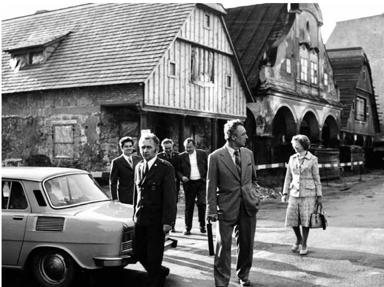
Ředitel Správy KRNP Jiří Svoboda s ministrem kultury Milanem Klusákem při prohlídce zdevastovaných historických domků, rekonstruovaných na hlavní informační středisko Správy (foto Jiří Bruník)
