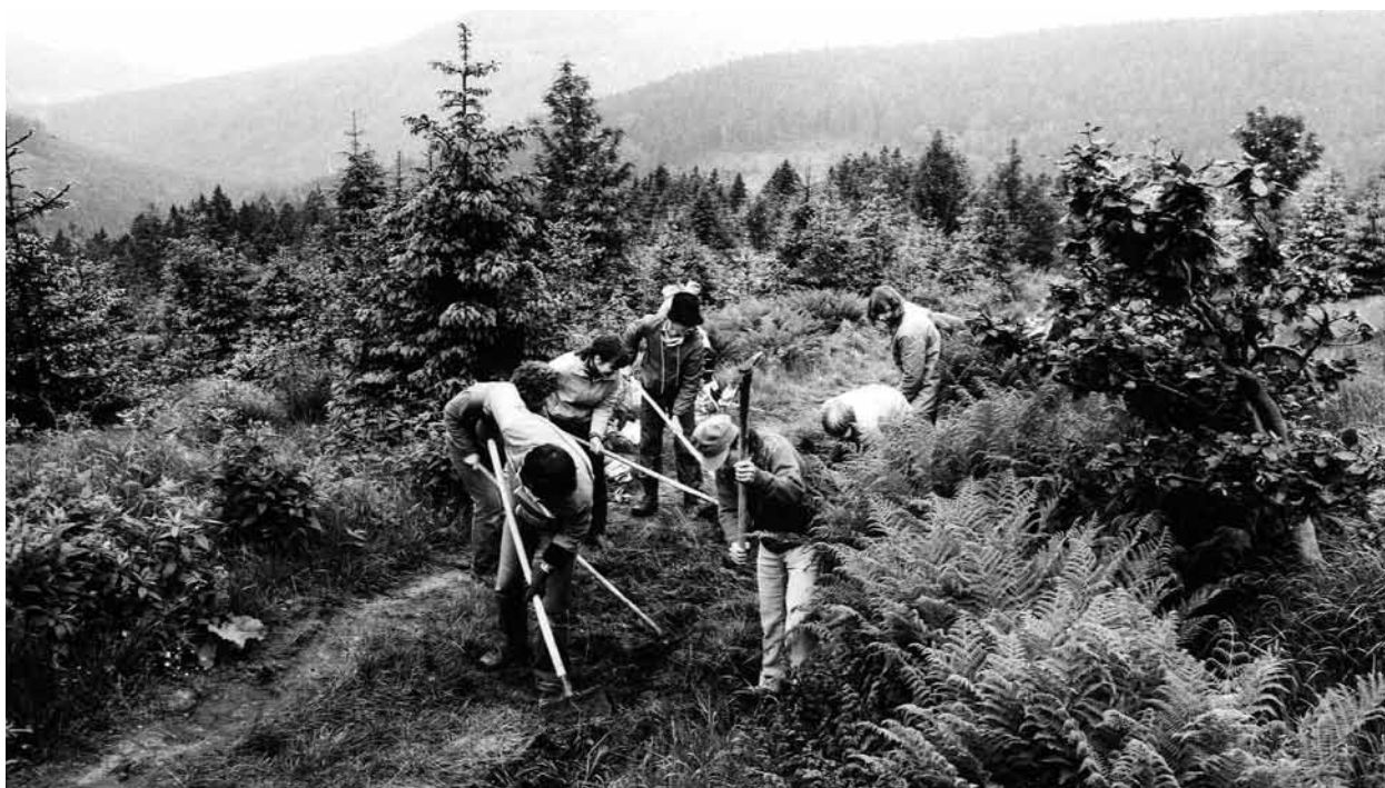
Akce Mladé ruce Krkonoším – úprava cesty a jejího odvodnění mezi Martinovou a Labskou boudou, 1984 (foto Jiří Bruník)
