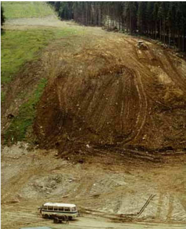
Nedostatečně stabilizovaný svah Velkého bubnu černé sjezdovky ve Svatém Petru během úprav v 70. letech 20. století (foto Jan Štursa)
