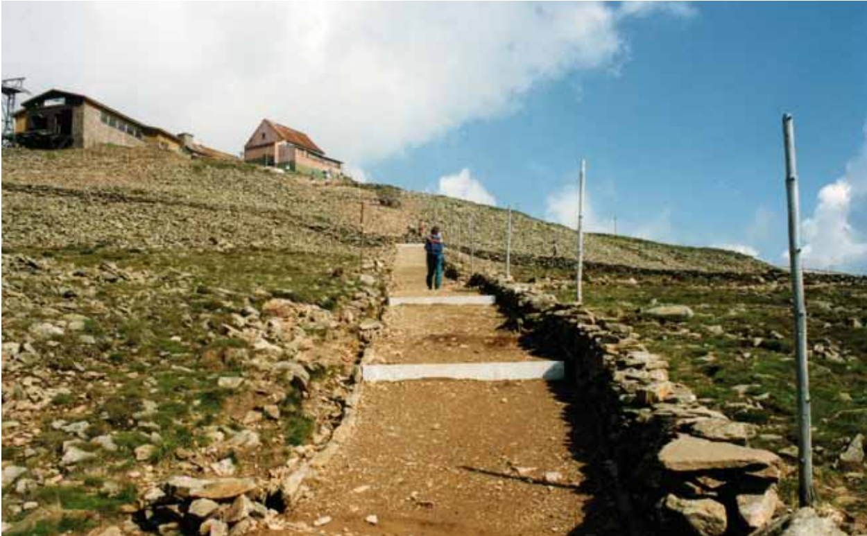
Celkový vzhled opravené cesty zlepšily i boční kamenné zídky, které jsou i účinnou ochranou proti nežádoucímu rozptylu turistů mimo těleso cesty (jedná se o I. zónu národního parku s nejpřísnějším režimem ochrany). Česká bouda ještě stojí... (foto Jan Štursa)
