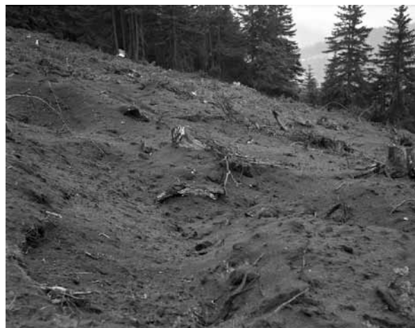
Žádné buldozery a přehrnování zeminy a kamení z jednoho konce sjezdovky na druhý. Po odstřelu pařezů členové a příznivci Spartaku Rokytnice s hráběmi a kolečky citlivě upravovali povrch nové sjezdovky před osetím (foto Jan Štursa)
