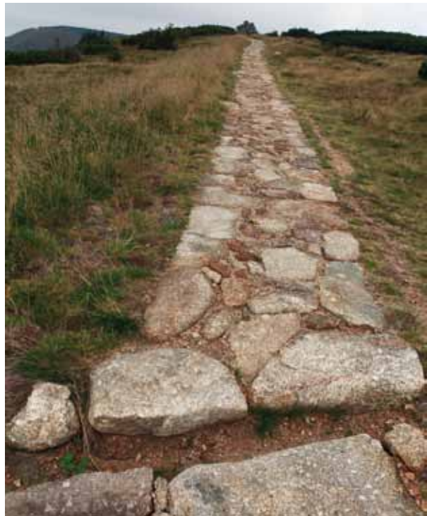
Cesta k Harrachovým kamenům je poměrně úzká a dlážděná žulovými kameny. Nahradila širší šterkovou cestu (2011, foto Kamila Antošová)
