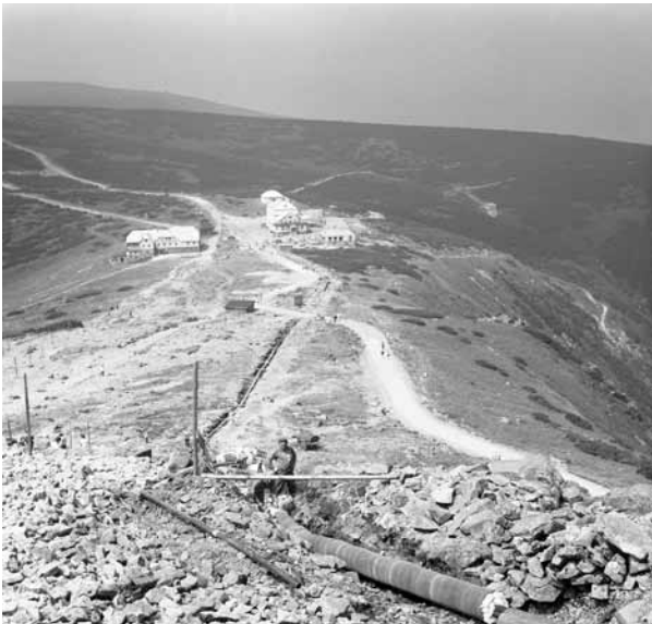
Výkop sdruženého vedení vody, elektřiny a telefonu, 1974. Přestože bylo mělce uložené vedení zaházeno kamením, je dnes znovu dobře patrné (foto Jan Štursa)
