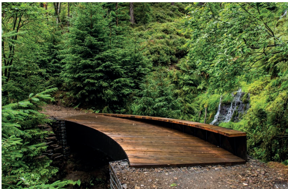
Lávka přes Hlubokou strouhu
