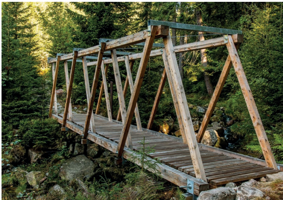
Lávka přes Medvědí potok
