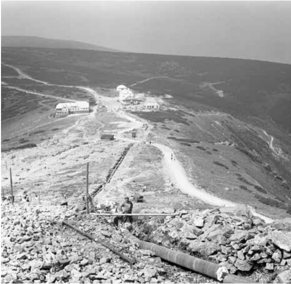
Aushubarbeiten für die gemeinsame Wasser-, Strom- und Telefonleitung, 1974. Obwohl die flach verlegte Leitung mit Steinen bedeckt wurde, ist sie bis heute deutlich zu erkennen (Foto Jan Štursa)
