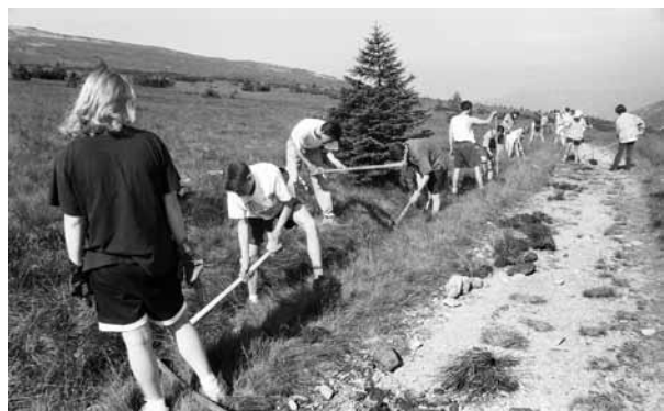
Internationaler Jugendeinsatz, Juni 1995. Die Teilnehmer erneuern das Entwässerungssystem am Weber-Weg zwischen Wiesenbaude (Luční bouda) und Ziegenrücken (Kozí hřbety), (Foto. Karel Hník)
