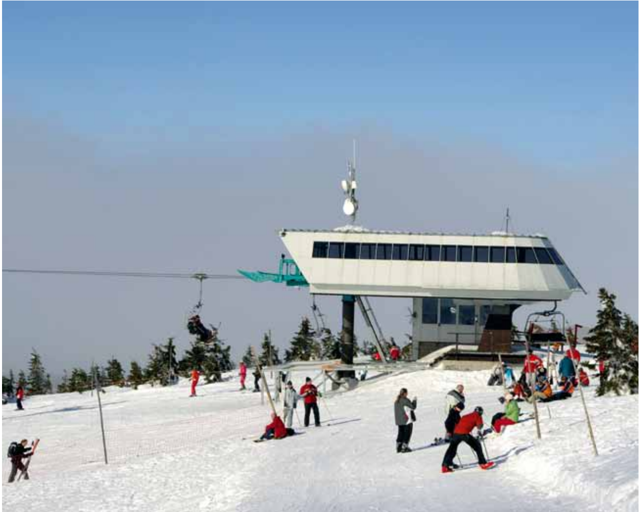
Bei guten Schneeverhältnissen transportiert der 4er Sessellift 1 800 Personen pro Stunde zum Gipfel des Kahlen Berges (Lysá hora), (Foto Kamila Antošová)
