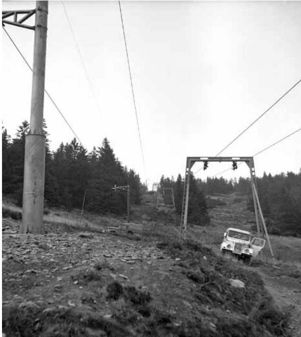
Keine Bulldozer und kein Hin- und Herschieben von Erd- und Gesteinsmassen von einem zum anderen Ende der Piste. Nach dem Heraussprengen der Baumstümpfe wurde das Terrain der neuen Piste von Mitgliedern und Anhängern des Spartak Rokytnice vor der Aussaat behutsam mit Harken und Schubkarren geebnet (Foto Jan Štursa)
