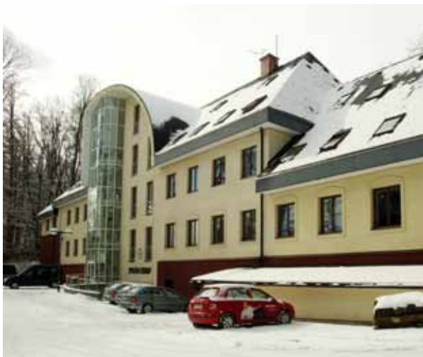
Die Abteilungen der KRNP-Verwaltung in Vrchlabí siedelten lange Zeit an verschiedenen Orten – im Schloss, im Museumsgebäude und in zwei provisorischen Holzbaracken. Nach dem Zusammenschluss mit dem Forstbetrieb wurde eine neue Zentrale errichtet (Fertigstellung im Jahre 1996, Foto Kamila Antošová)
