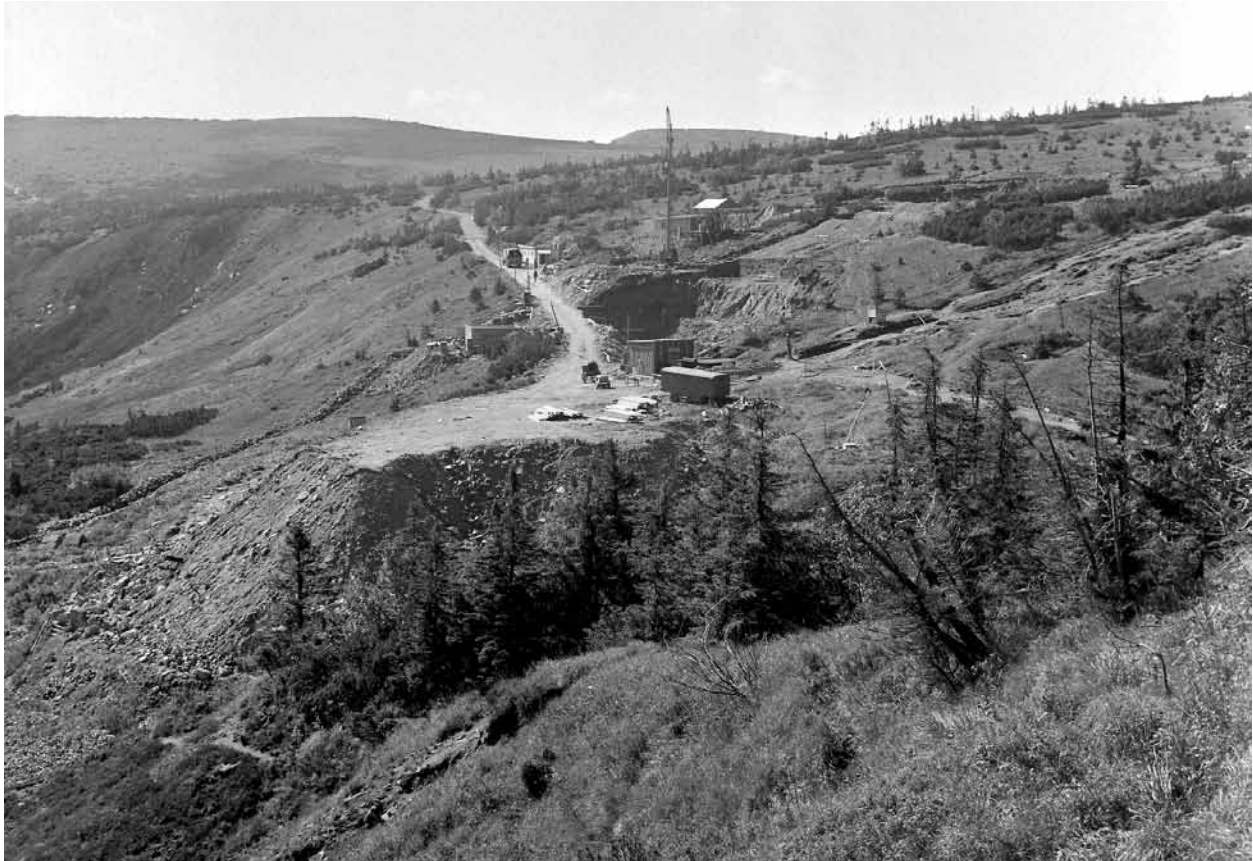
Dem Bau der Neuen ‚Labská bouda‘ gingen gewaltige Erd- und Tiefbauarbeiten voraus, welche die Natur in der Umgebung der Elbgruben unwiederbringlich zeichneten (Foto Jan Štursa)
