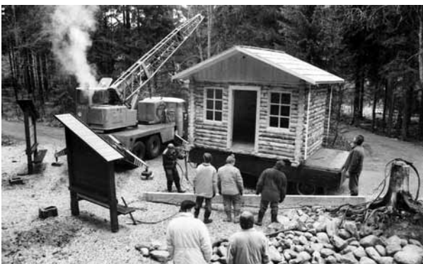
Installation der Blockhütte des Geländedienstes vor Dívčí lávky (Mädelsteig) im Oktober 1994. Im Sommer sollte sie als Informationsstelle dienen, im Winter wiederum zur Unterstützung der Skiläufer auf der ‚Trimm-dich-Loipe‘. Ringsherum stehen Tafeln mit aufschlussreichen Texten, rechts das präparierte Wurzelwerk eines Fichtenstumpfs (Foto Karel Hník)
