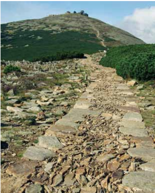
Rekonstruierter Weg über den Riesenkamm (Obří hřeben), (2010, Foto Kamila Antošová)
