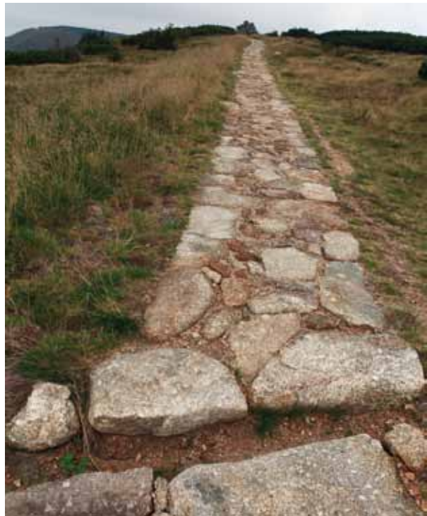
Der mit Granitstein gepflasterte Weg zu den Harrachsteinen (Harrachové kameny) ist recht schmal. Er ersetzt einen viel breiteren Schotterweg (2011, Foto Kamila Antošová)
