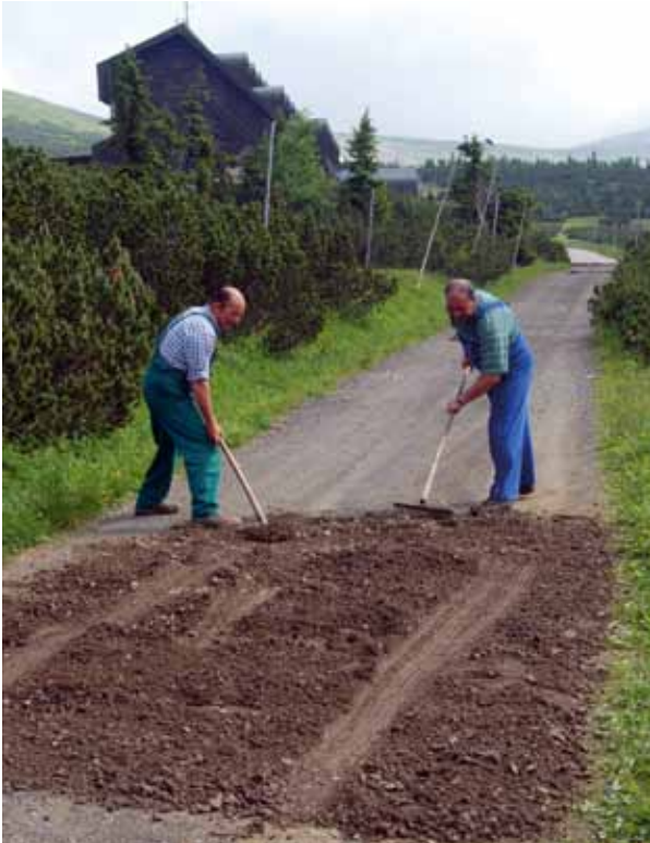
Gebirgswege bedürfen in Bezug auf Entwässerung und Oberfläche von Frühling bis Herbst regelmäßiger Pflege, ansonsten werden sie wortwörtlich weggeschwemmt. Jan Růžička (rechts) war über 30 Jahre lang Wegewart der KRNAP-Verwaltung (2006, Foto Jitka Kopáčová)
