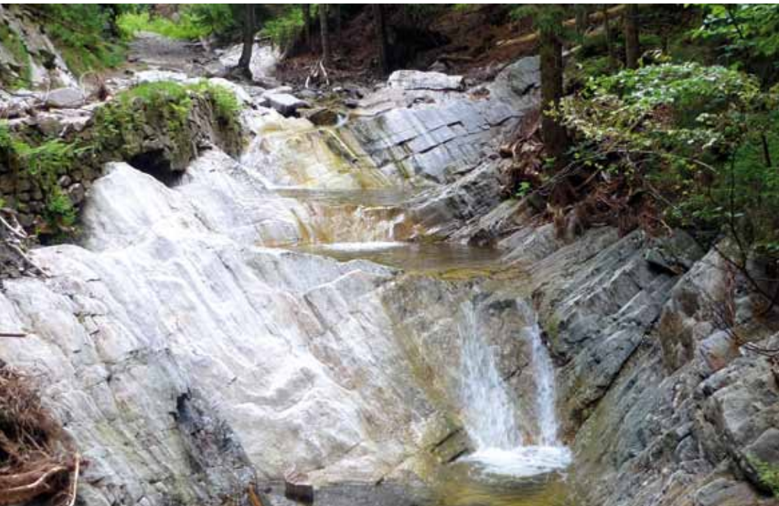
Povodeň 2. června 2013 zasáhla jen velmi úzký pruh východních Krkonoš, ale přesto ve třech údolích napáchala neuvěřitelné škody. Na některých místech „vymetla“ údolní dno až na skalní podloží (Těsný důl)
