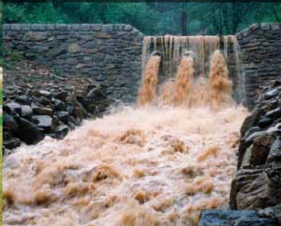
Protierozní zděná přehrážka na Vebrově potoce, vybudovaná po povodni. Za zvýšeného vodního stavu náznorně dokumentuje svoji funkčnost; propouští pouze vodu a zachycuje pevné splaveniny.
