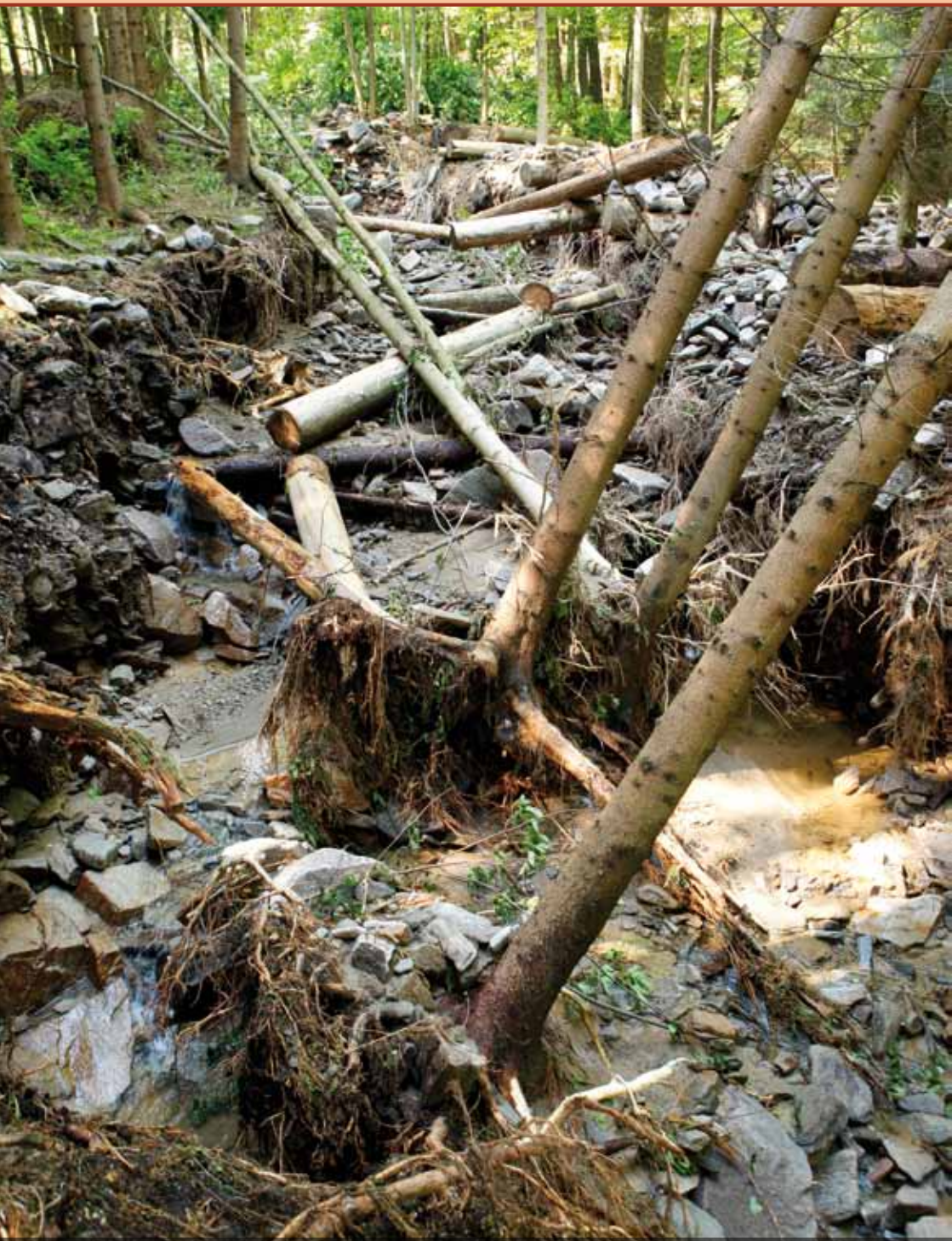
Jinde erozně vyhloubila údolní sedimenty do podoby strží (dolní část Honzova potoka)
