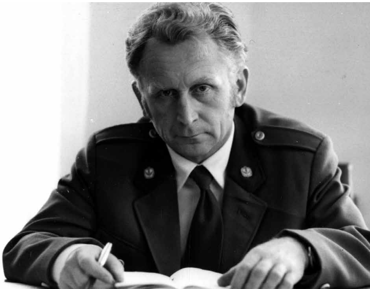
Za jeho působení byly dokončeny rekonstrukce všech muzejních objektů a instalovány nové expozice
