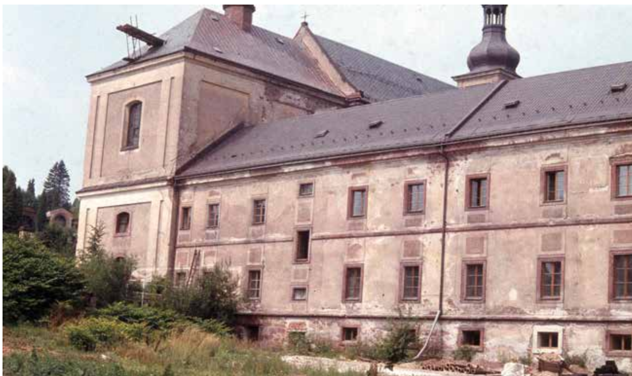
Generální rekonstrukce střech celého areálu byla prvním a nezbytným krokem k dalšímu postupu prací na obnově budovy, ale též poskytla muzeu nové depozitární prostory v podkroví
