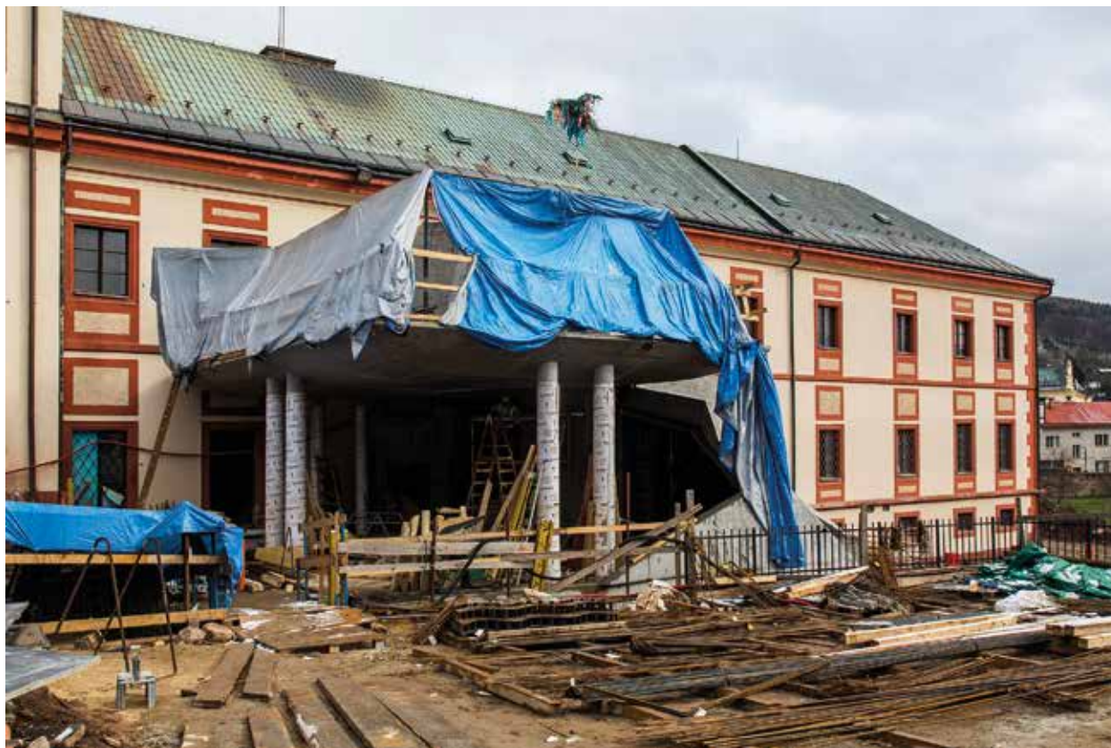
V průběhu stavby nového vstupu
