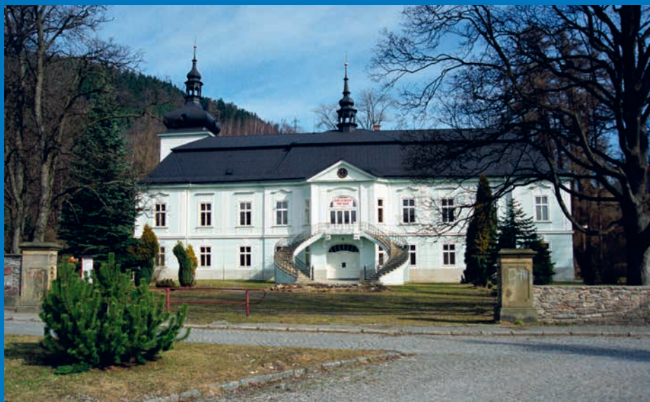
Průčelí zámku v Horním Maršově v podobě před požárem v roce 2018
