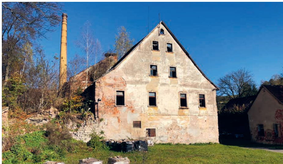
Jihozápadní průčelí bývalé tvrze v Rudníku
