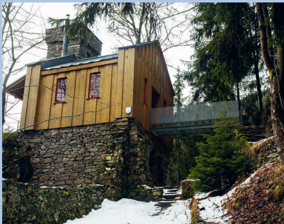
Novostavba na starých základech letohrádku Aichelburg
