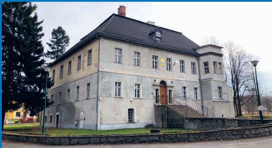
Celkový pohled na vstupní stranu zámku v Bukowci
