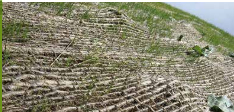
Na místech náchylnějších k erozi lze zelené seno zajistit geotextilními rohožemi.
