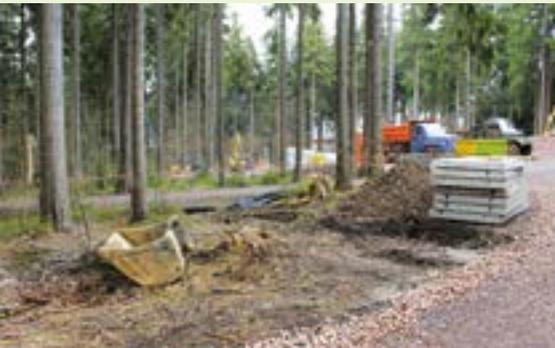
*Ein Bagger riss die Baumstümpfe aus dem Boden und planierte den Boden an den Stellen, an denen schwere Baukräne in den Wald zu transportieren waren. Hier verlegten die Bauleute einen speziellen „Teppich“ – sie schütteten Schotter auf, auf dem sie anschließend Betonplatten verlegten.*
