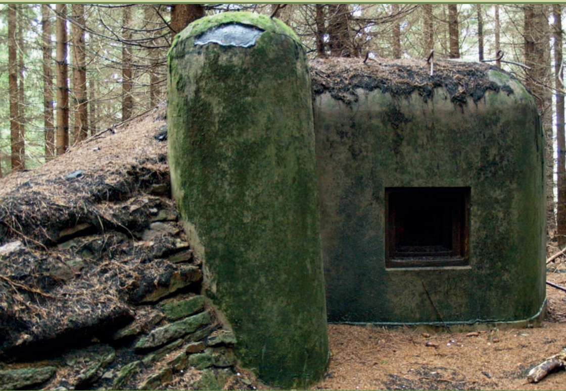
Objekt č. 3/A-140 úseku Z-2 na Dlouhém hřebeni byl pro sklonové podmínky postaven v šikmém provedení. Patrná je kamenná rovnanina záhozu, zvyšující ochranu čelní stěny objektu při nepřátelském ostřelování (foto Jan Juřena, 2014)
