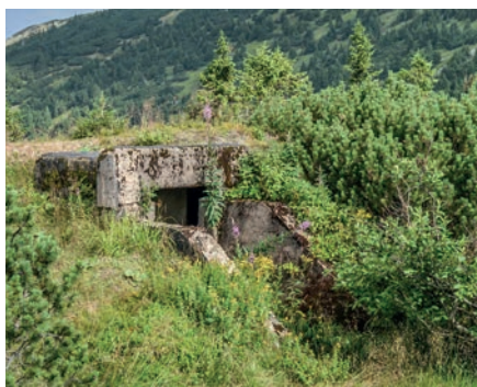
V blízkosti srubových baráků na Výrovce (přibližně 100 m severně) byla v létě 1938 postavena kobka na ruční granáty a pistolové rakety. Kobka je zhotovena z tvárnice a železobetonových desek. Je rozdělena na dvě místnosti, neboť oba druhy munice patří do různých skupin, které musely být uskladněny odděleně. Celá stavba byla zahrnuta hlínou a odmrována (foto Jan Juřena, 2013)
