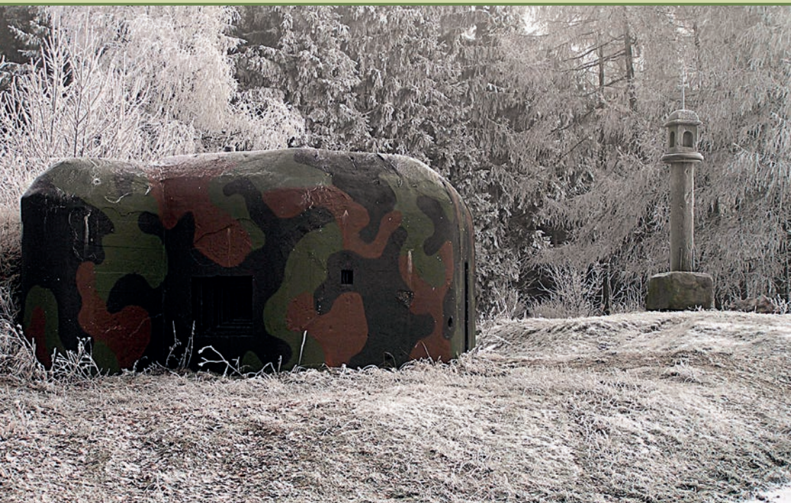
Objekt lehkého opevnění z roku 1937 č. 54/A-140 úseku G-3 v prostoru staveniště tvrze Ježová hora (do počátku roku 1938 pod názvem tvrz Stachelberg). Dne 21. září 1938 byl u toho objektu postřelen voják hraničářského pluku 17 Josef Beran. Ačkoliv byl ihned převezen do Všeobecné Masarykovy nemocnice v Trutnově, zraněním krátce po půlnoci druhého dne podlehl (foto Jakub Mikolášek, 2005)
