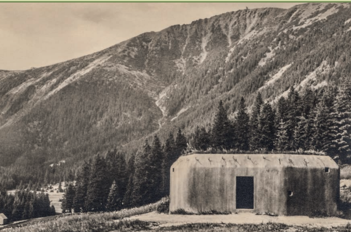
Objekt lehkého opevnění nového typu (řopík) č. 104/A-120 úseku Z-3 (původně úseku H-1) umístěný v Obřím dole. V Krkonoších měly dle původních předpokladů řopíky přehradit pouze komunikace. Později ale bylo stanoveno, že celé hlavní obranné postavení ve II. sboru (od Orlických hor až po Labe) bude opevněno dvěma sledy těchto objektů (archiv Jednoty ČsOL v Mladé Boleslavi)
