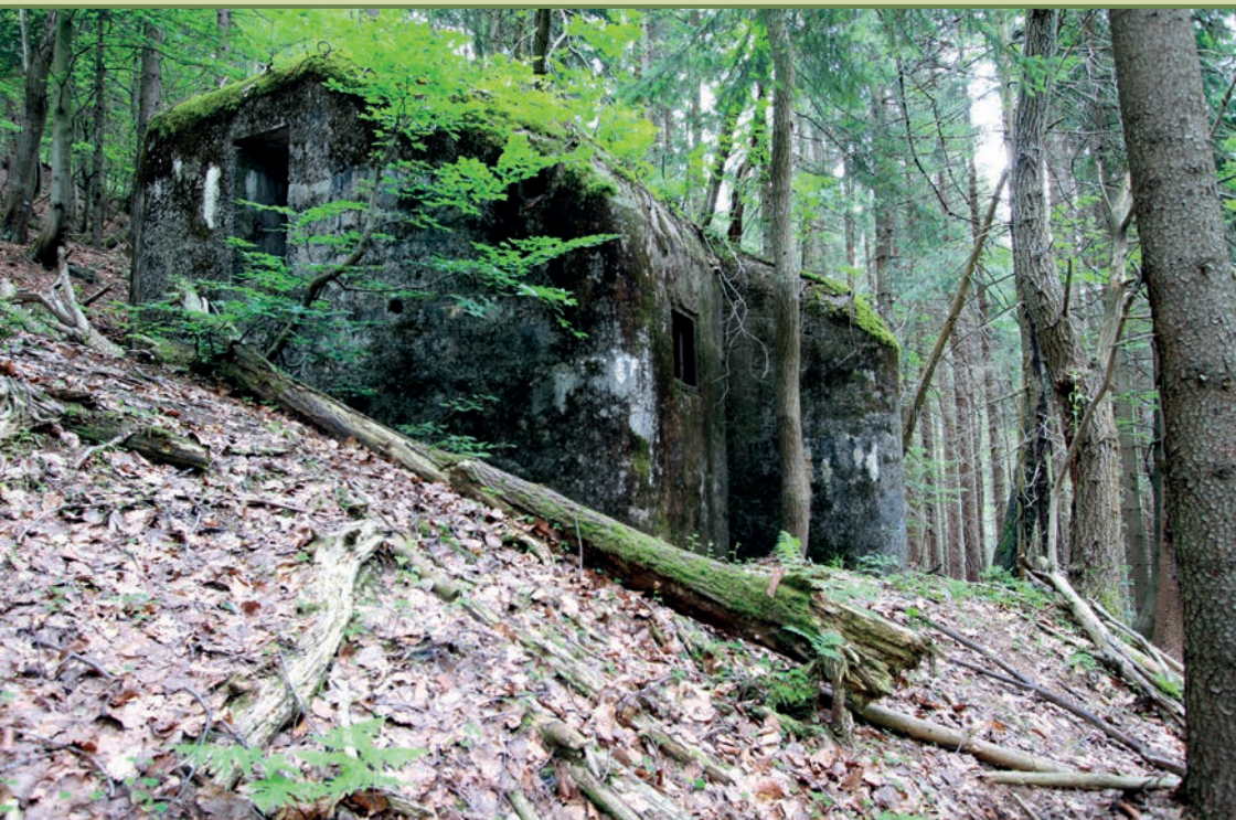
Objekt č. 68/A-180 úseku H-2 byl vzhledem k umístění v prudkém svahu vyprojektován ve výškově lomeném provedení, jeho levá střílna mířící vzhůru je navíc vykloněna, aby byl umožněn účinný postřel svahu (foto Jan Juřena, 2013)
