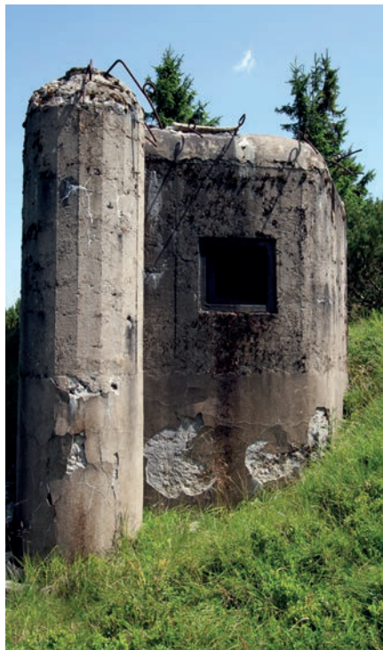
Objekty na konci západní části úseku H-3 se nacházejí v hrubé betonáži, jako tato pevnůstka č. 34/A-160. Byla vybetonována 15. září 1938, a tak se u ní nestihly osadit různé ocelové části, jako např. zárubně, konzole pro uchycení ventilátoru nebo mřížky odvětrávání (foto Michal Souček, 2013)
