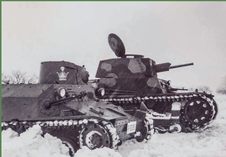
Prototyp tančičku AH-IV určený pro Írán (vlevo) a prototyp lehkého tanku Praga P-II-a, který byl neúspěšně nabízen československé armádě. Fotografie vznikla během zkoušek v Krkonoších v zimě roku 1937 (archiv VHA Praha)
