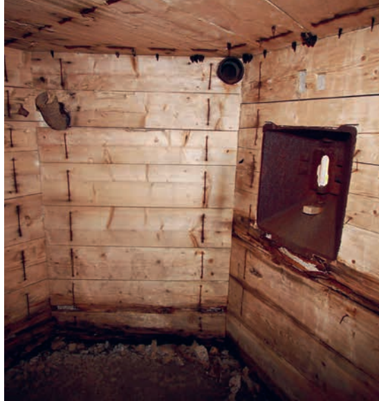
Interiér několika pevnůstek v úseku H-1 se dochoval včetně dřevěného bednění. To bylo po ukončení betonáže ponecháno na svém místě zejména za účelem ochrany osádky před úlomky betonu při nepřátelském ostřelování objektu (foto Michal Souček, 2013)
