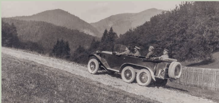
Provozní zkoušky velitelského šestikolového automobilu Tatra T26/30 v Krkonoších ke konci 20. let minulého století (archiv VHA Praha)
