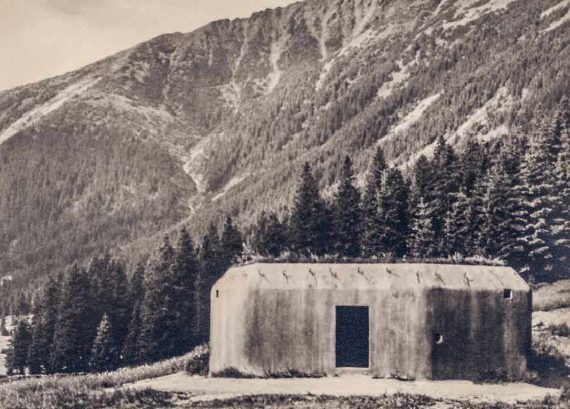
Objekt lehkého opevnění nového typu (řopík) č. 104/A-120 úseku Z-3 (původně úseku H-1) umístěný v Obřím dole. V Krkonoších měly dle původních předpokladů řopíky přehradit pouze komunikace. Později ale bylo stanoveno, že celé hlavní obranné postavení ve II. sboru (od Orlických hor až po Labe) bude opevněno dvěma sledy těchto objektů (archiv Jednoty ČsOL v Mladé Boleslavi)
