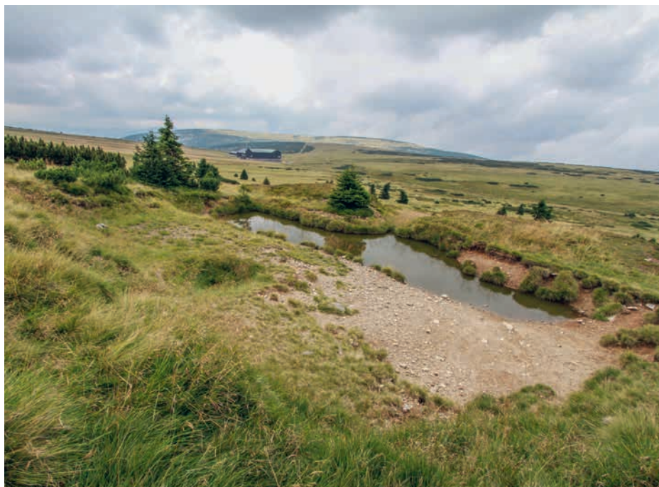
Výkop pro pěchotní srub KrK-L-S II pod Studniční horou (v pozadí Luční bouda). Objekt měl být vyzbrojen dvěma 4cm kanony proti útočné vzbě vz. 36, čtyřmi kulomety vz. 37 (těžkými kulomety) osazenými ve dvou lafetách pro dva kulomety a jedním kulometem vz. 37 umístěným ve zvonu ve stropní desce objektu. Do ukončení stavebních prací na počátku října 1938 se výkop objektu nepodařilo dokončit (foto Michal Souček, 2013)
