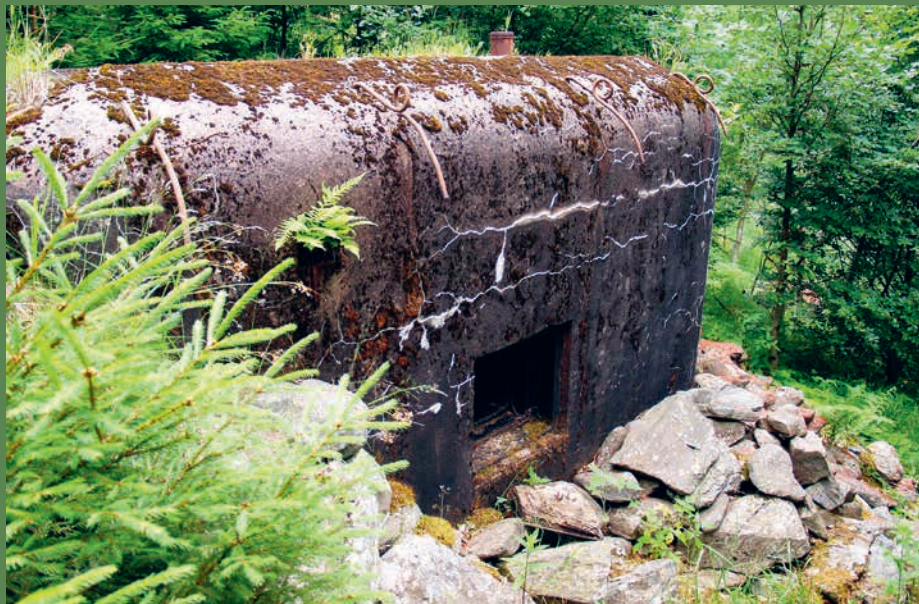
Silniční klesající od Pomezních Bud měly mimo jiné přehradit svou čelní palbou dvě druhosledové pevnůstky č. 293/E a č. 294/E úseku Z-3, proto byly betonovány nejdříve. Zatímco objekt č. 293/E se nachází v těsné blízkosti silnice z Maršova na Pomezní Boudy, jeho soused byl postaven na druhé straně nad řečištěm Úpy (foto Jan Juřena, 2014)
