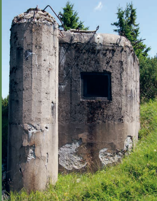
Objekty na konci západní části úseku H-3 se nacházejí v hrubé betonáži, jako tato pevnůstka č. 34/A-160. Byla vybetonována 15. září 1938, a tak se u ní nestihly osadit různé ocelové části, jako např. zárubně, konzole pro uchycení ventilátoru nebo mřížky odvětrávání (foto Michal Souček, 2013)
