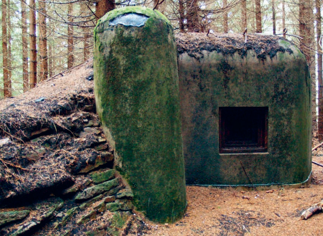
Objekt č. 3/A-140 úseku Z-2 na Dlouhém hřebeni byl pro sklonové podmínky postaven v šikmém provedení. Patrná je kamenná rovnanina záhozu, zvyšující ochranu čelní stěny objektu při nepřátelském ostřelování (foto Jan Juřena, 2014)
